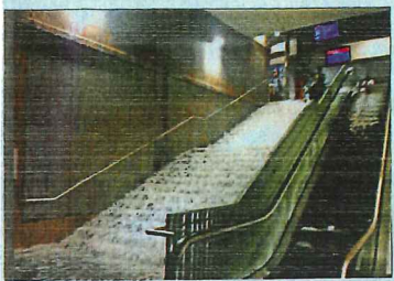
En pleine tempête, l'accès au passage sous voles de la gare s'est mué en cascade. HARBON/NOUSSADER
